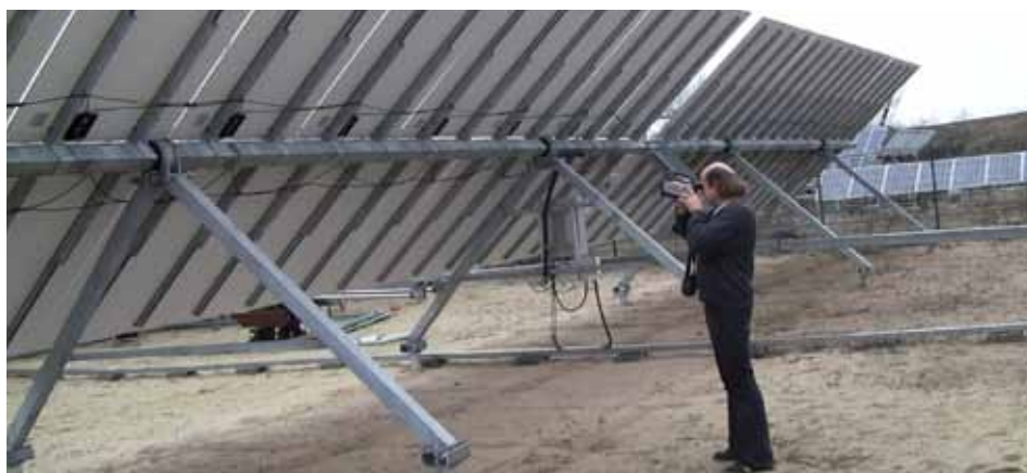
Volker Denzler, operatore termografico esperto presso il dipartimento dei servizi di postvendita, acquisisce immagini termiche dal retro di un modulo, per evitare riflessi.
