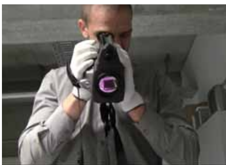
Oliver Frank, Team Manager R&D presso SOLON, effettua un controllo degli shunt utilizzando una termocamera FLIR.
