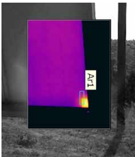
Questa immagine FLIR Picture-in-Picture mostra una cella surriscaldata a causa di un'ombra proveniente da un sistema di allarme nelle vicinanze.
