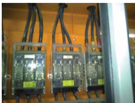
L'ispezione rileva l'esistenza di anomalie nella zona dei cavi vicini ai fusibili protetti da plexiglas. Grazie a MeterLink, i valori letti dalla pinza amperometrica vengono visualizzati sull'immagine termografica.
