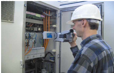
6. Operatore durante ispezione di centralina
